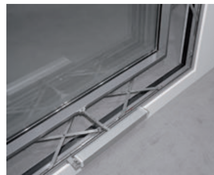
Деталь ножницы параллельно-выставляемое окно
