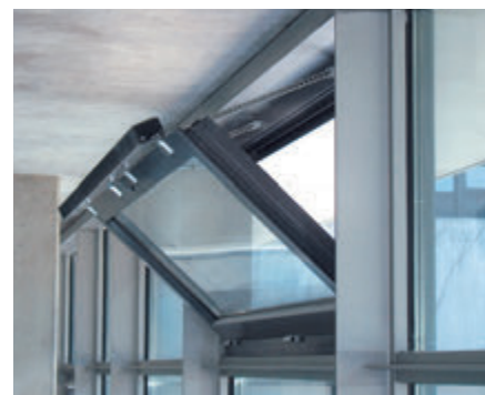
Цепной привод K60-Tandem, откидное вовнутрь
