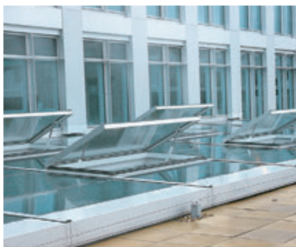
Открывание люков винтовым приводом S80
