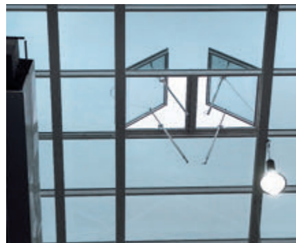
Люк с винтовым приводом S80-Tandem
