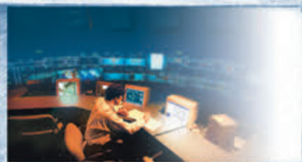
Системы управления зданием
